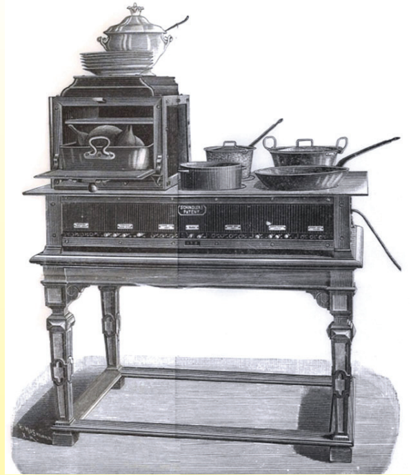
1898 หม้อหุงข้าวไฟฟ้า สิทธิบัตรของ Grimm, Schindler-Jenny (เอกสารพิพิธภัณฑฯ Ultimheat)
